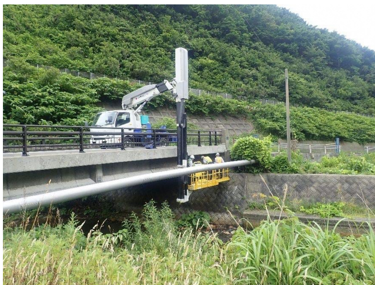
従来の点検方法（橋梁点検車）
